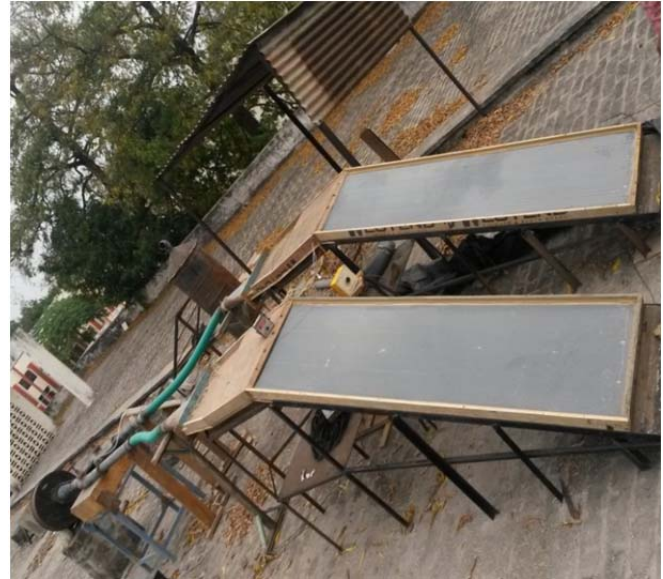
Dig- Actual set up of air heater
